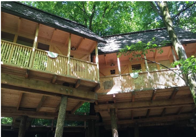
Slika 14 Hišice na drevesih v Garden Villageu. Foto: Mike Burnard.
